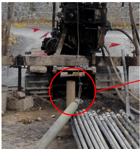
钻孔下套管护壁
