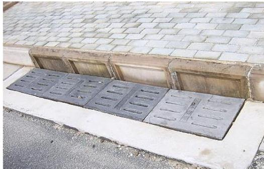
调查五：国标图集 05S518《雨水口》中各种型式雨水口给出相同泄水能力；对以往工程设计图纸调查，一般道路坡度下雨水口间距采用经验值 30 米。
